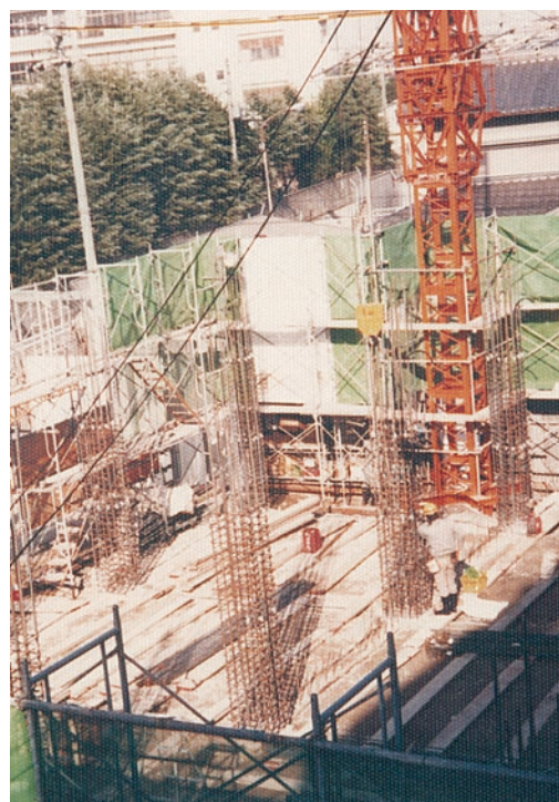
旧鶴見緑地病院の増築工事
